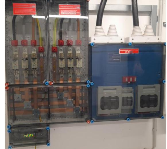
Elektrotechnik überdimensioniert; Komponenten für IT-Netzwerk und Last-/Lademanagement nicht vorhanden
