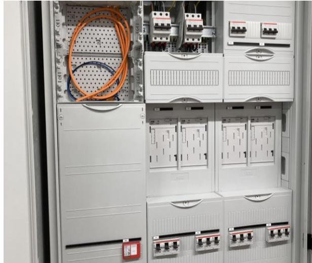
Elektrotechnik für Dauerlastbetrieb unzureichend; IT-Netzwerk für Last-/Lademanagement fehlen
