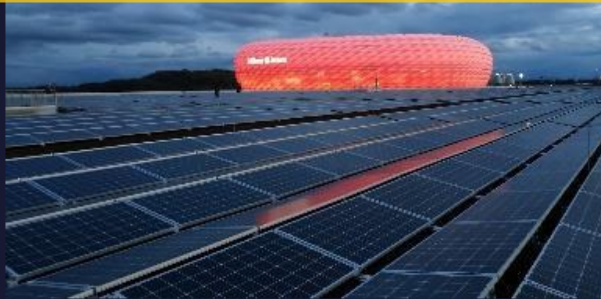
Allianz Arena München 834kWp
